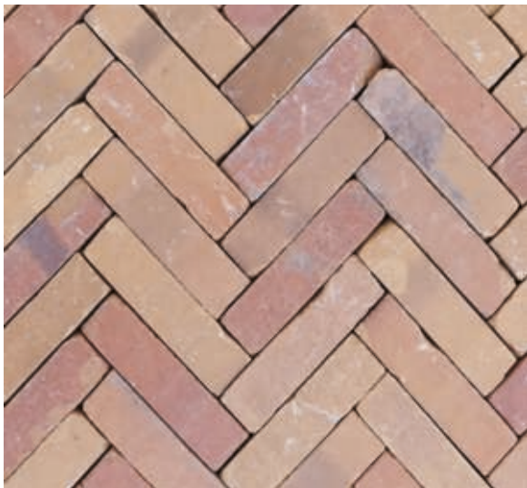
Pflaster Fischgrät hochkant verlegt
