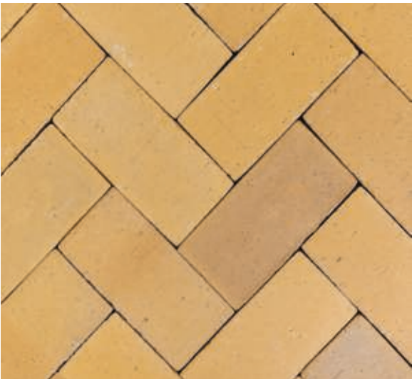
Pflaster Fischgrät flach verlegt
