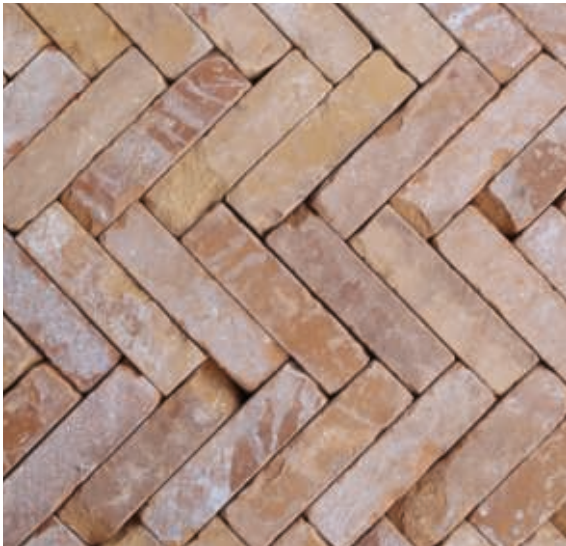
Pflaster Fischgrät hochkant verlegt
