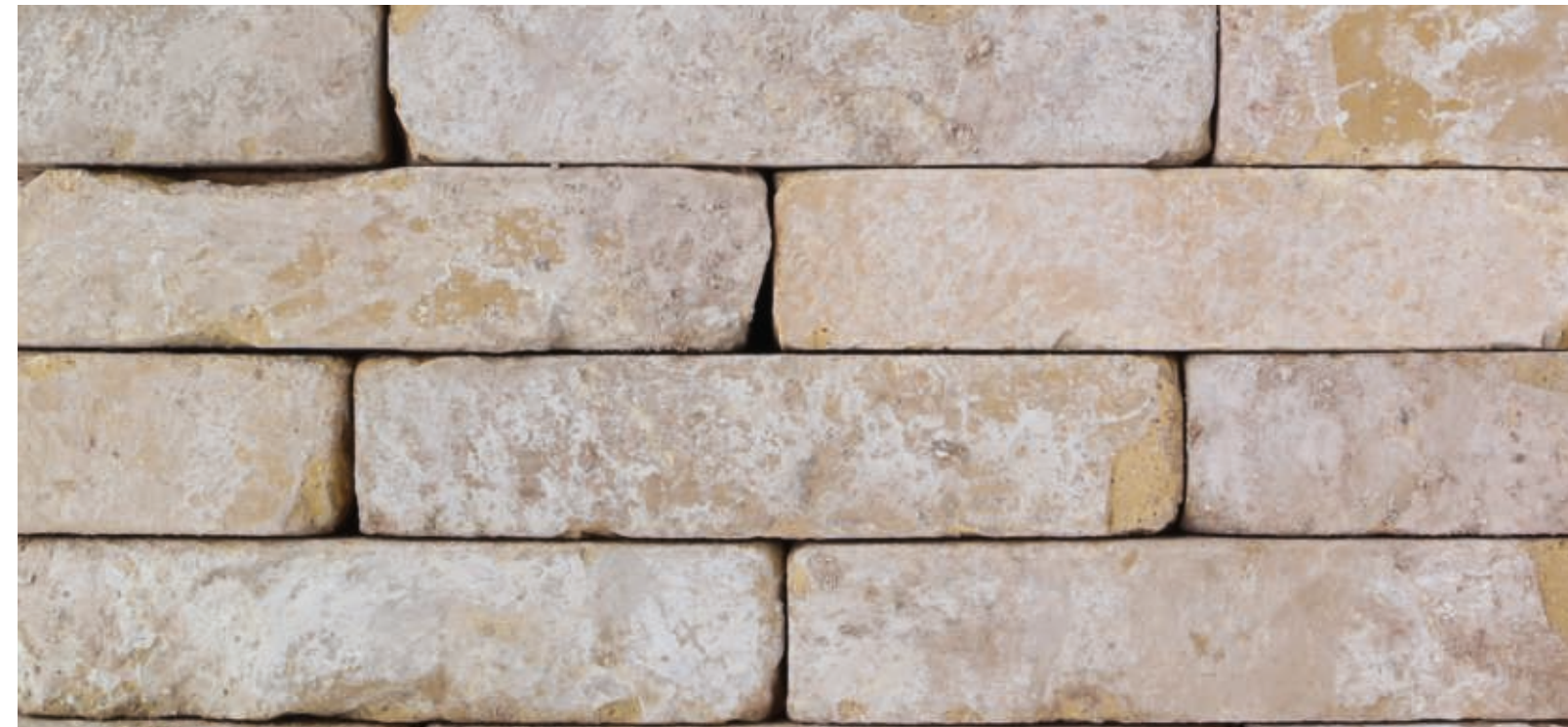
Mauerklinker Läuferverband oder Pflasterklinker hochkant
