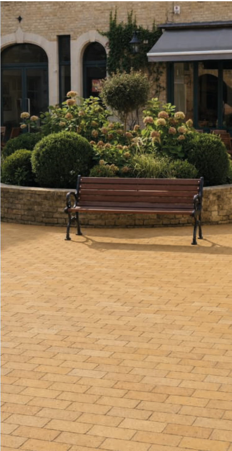
Pflaster Läuferverband flach verlegt
