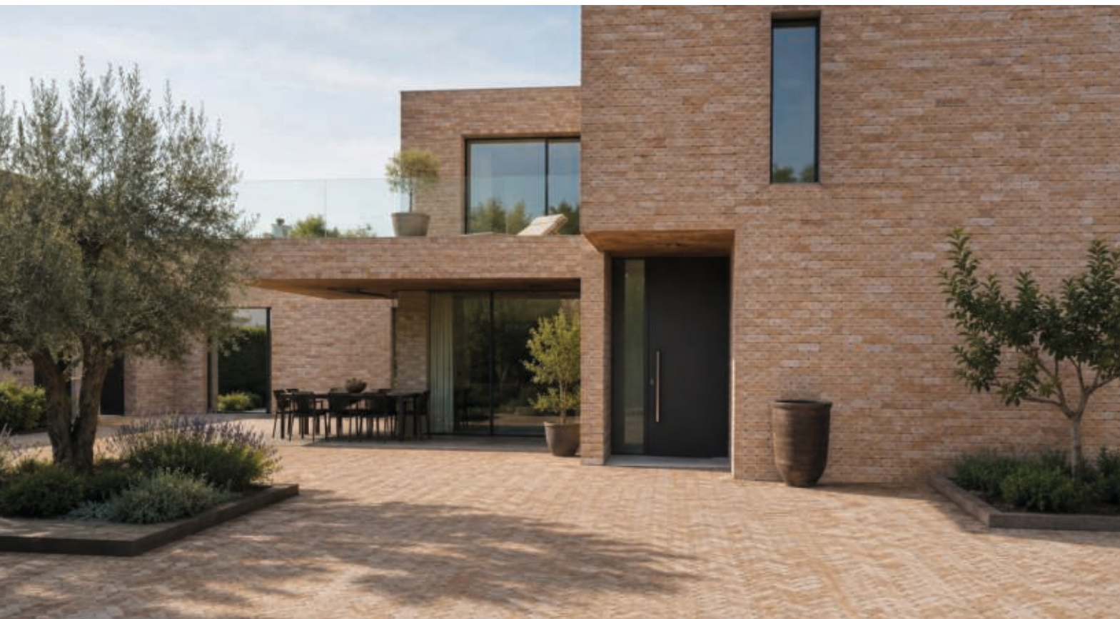
Ansicht: Mauerklinker Läuferverband oder Pflasterklinker hochkant
