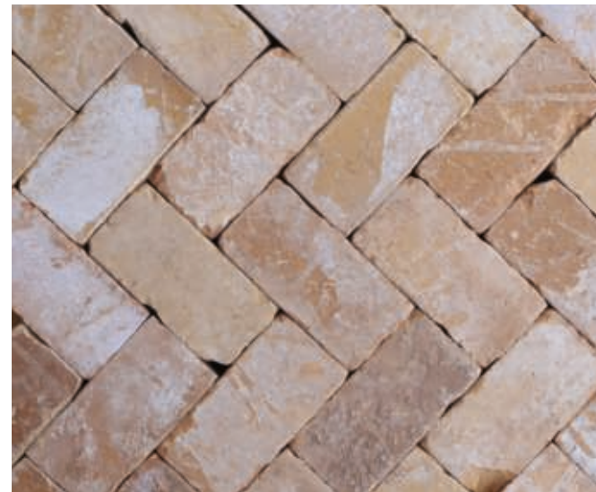
Pflaster Fischgrät flach verlegt
