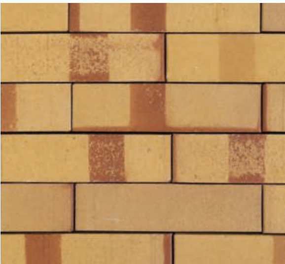
Läuferverband Mauer oder Pflaster hochkant
