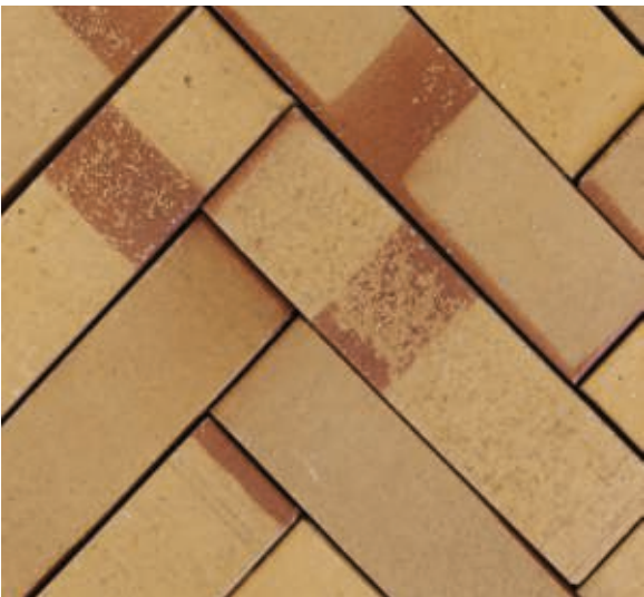
Pflaster Fischgrät hochkant verlegt
