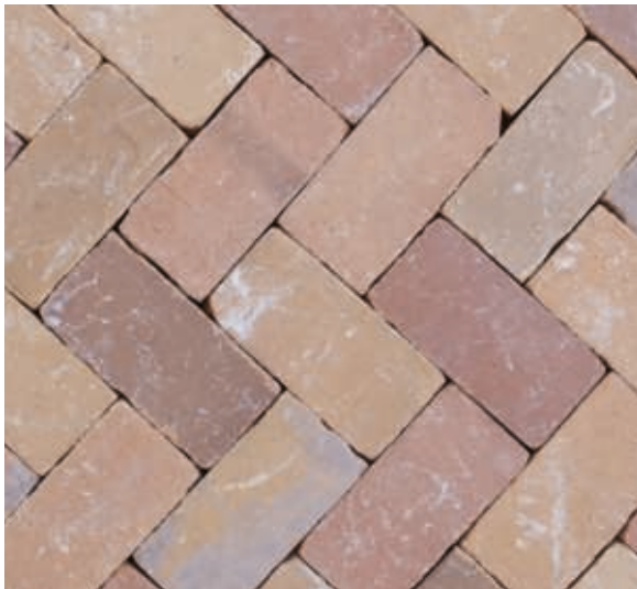
Pflaster Fischgrät flach verlegt
