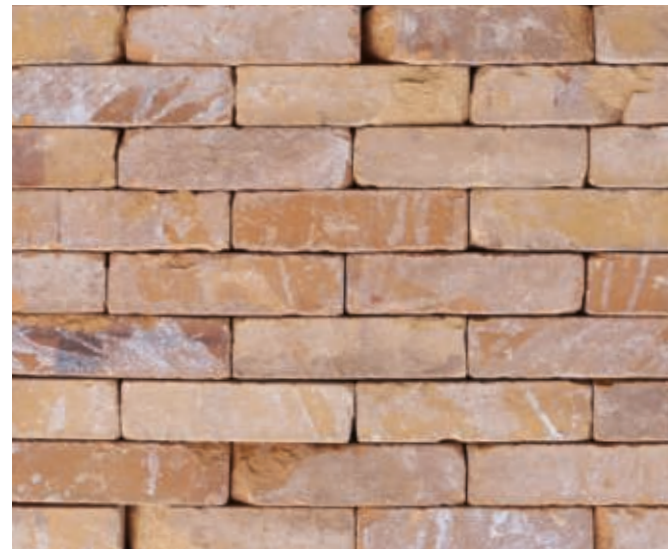
Mauerklinker Läuferverband
