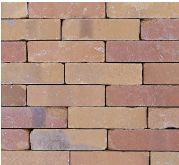
Läuferverband Mauer oder Pflaster hochkant
