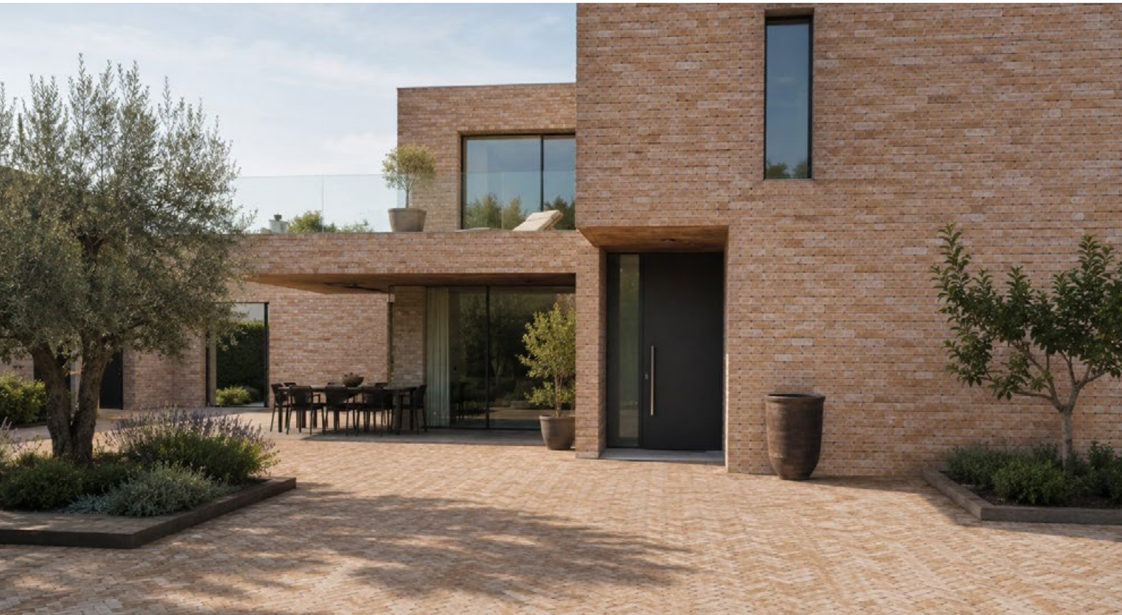
Ansicht: Mauerklinker Läuferverband oder Pflasterklinker hochkant
