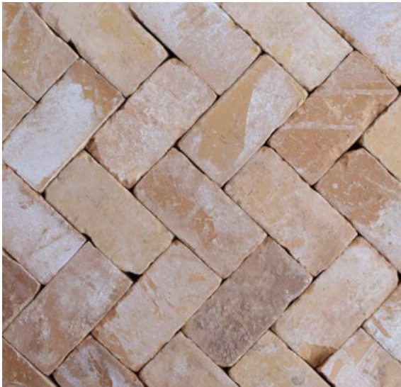
Pflaster Fischgrät flach verlegt
