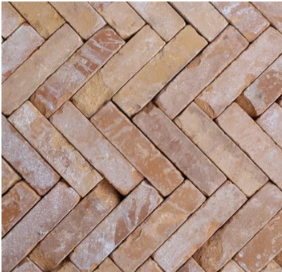
Pflaster Fischgrät hochkant verlegt
