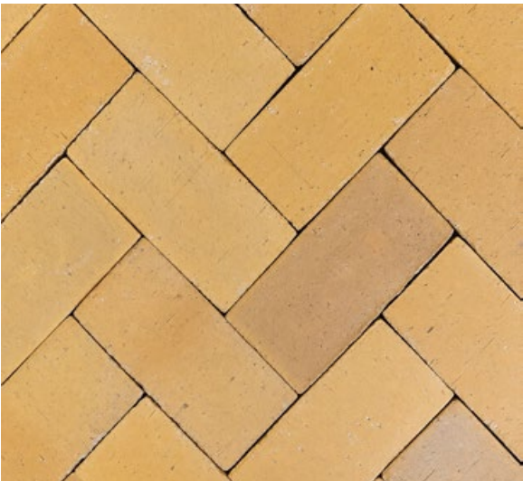
Pflaster Fischgrät flach verlegt
