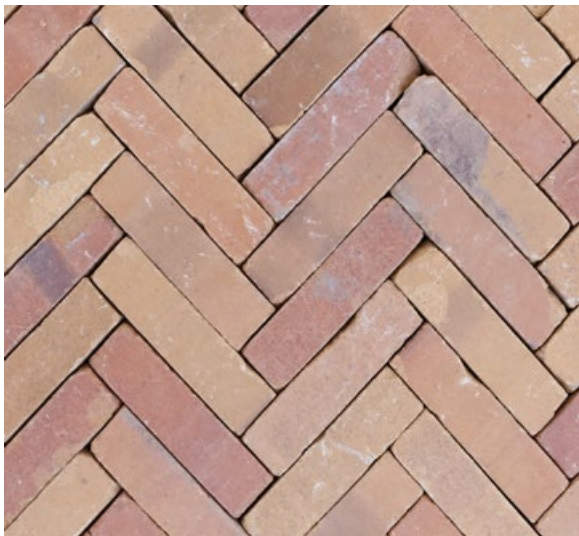
Pflaster Fischgrät hochkant verlegt
